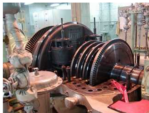
蒸気タービン開放点検
