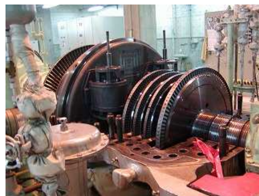
蒸気タービン開放点検
