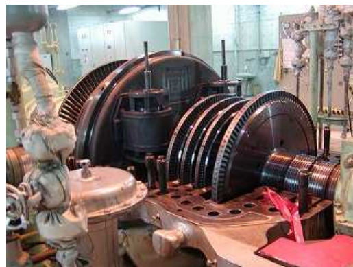
蒸気タービン開放点検
