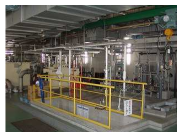
微生物の力で「きれいな水」に処理する設備
