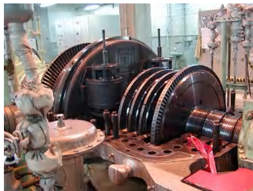
蒸気タービン開放点検
