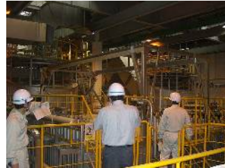
施設内設備の点検の様子
