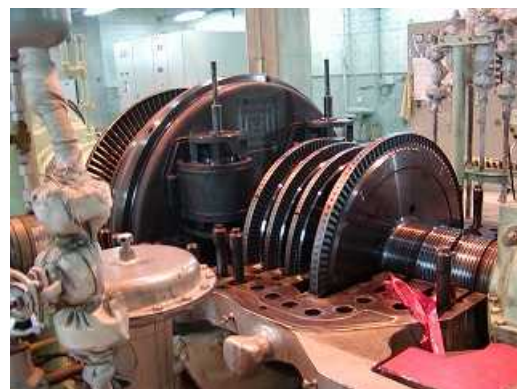
蒸気タービン開放点検
