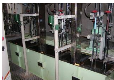
薬品で「きれいな水」に処理する設備
