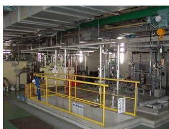
微生物の力で「きれいな水」に処理する設備
