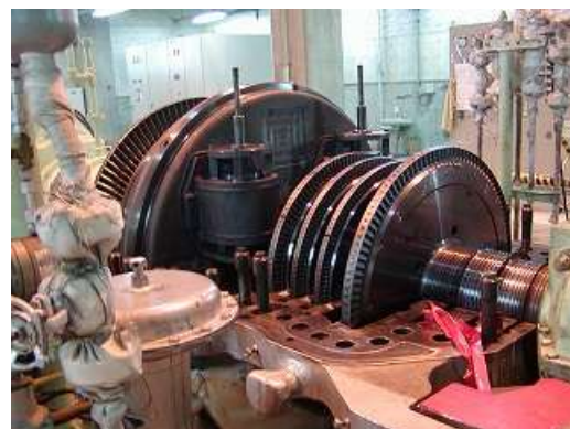
蒸気タービン開放点検
