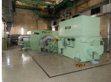
🔌 蒸気タービン発電機
